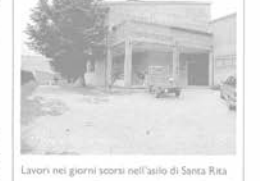
Lavori nei giorni scorsi nell'asilo di Santa Rita
